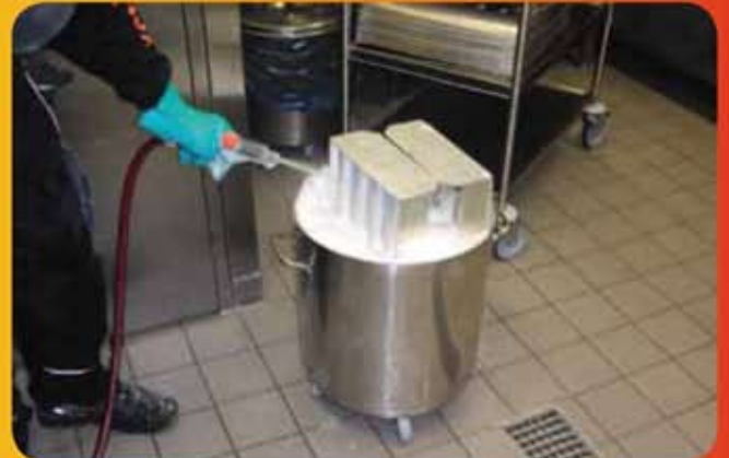
Fettabscheider einer Küchenablufthaube im Chemiebad. Falls geeignete Spülmaschinen vor Ort fehlen erfolgt die Reinigung notfalls auch per Hand.
