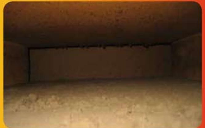
Blick in den verschmutzten Luftkanal einer RLT-Anlage. Deutlich zu sehen sind die Staub- und Schmutzablagerungen.
